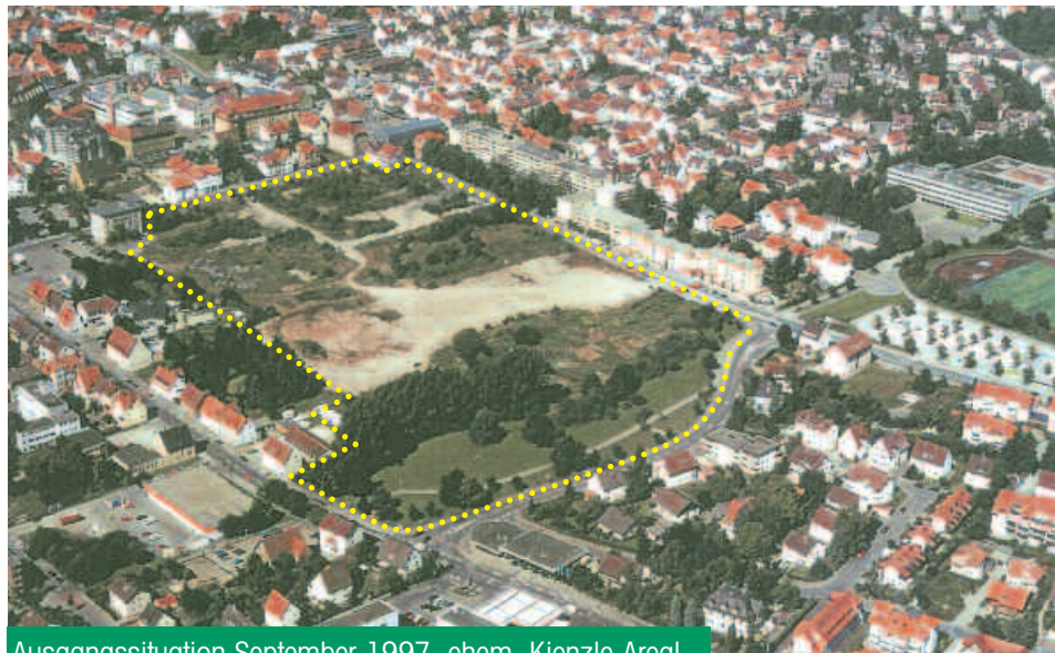
Ausgangssituation September 1997, ehem. Kienzle-Areal
